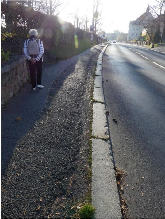
Die Fußwege beiderseits der Straße bis zur Brücke weisen zahlreiche Schäden auf, da nach der Verlegung von Leitungen die Kabelgräben mit minderwertigem Asphalt verschlossen wurden.
